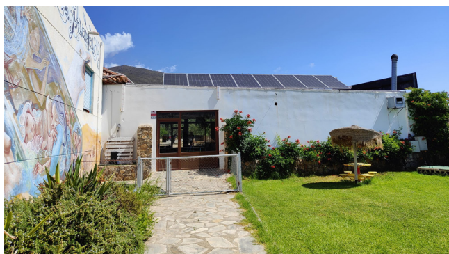
/ Central energética ubicada en un edificio de usos múltiples de Almócita
